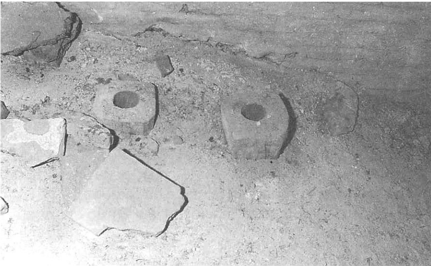
Passage des cordes des anciennes cloches dans les combles (voir revue n° 9)
