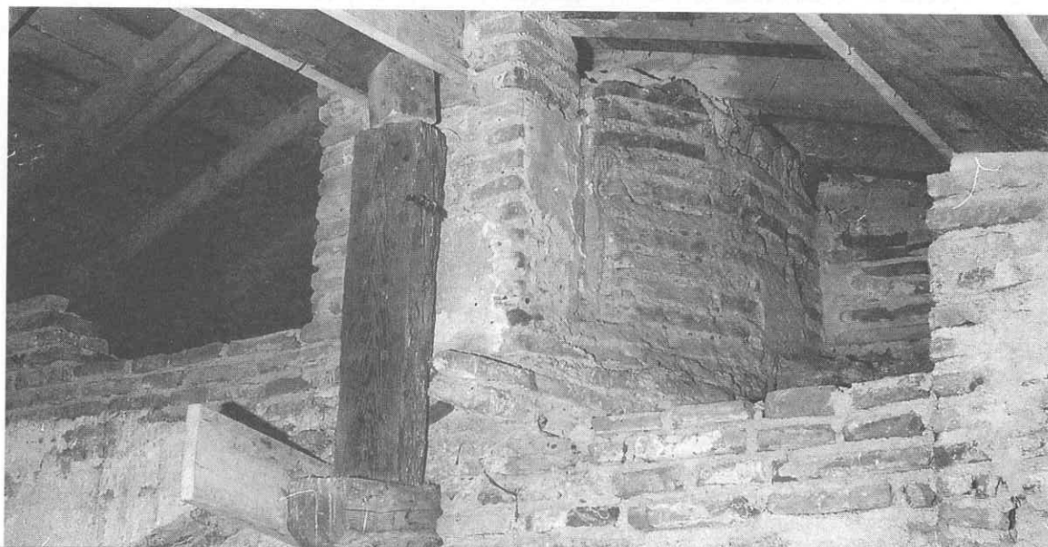
Niche intérieure des anciennes cloches.
