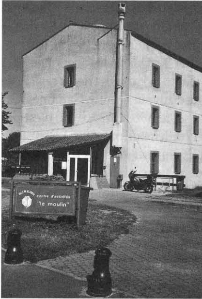
Le bâtiment de l'ancien moulin
