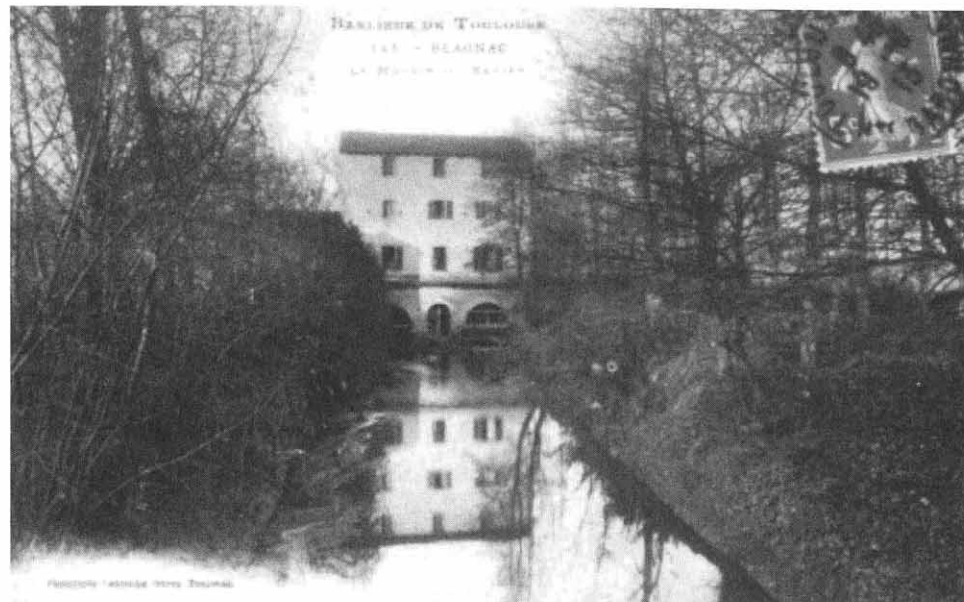
Le canalet et le moulin.
