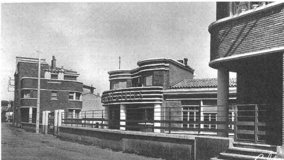
Façade de l'école de filles.
