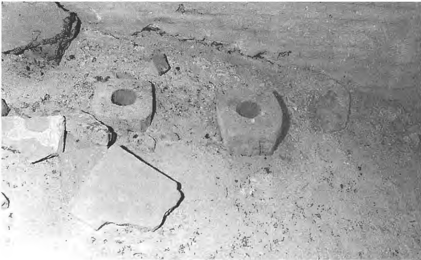
Passage des cordes des anciennes cloches dans les combles (voir revue n° 9)
