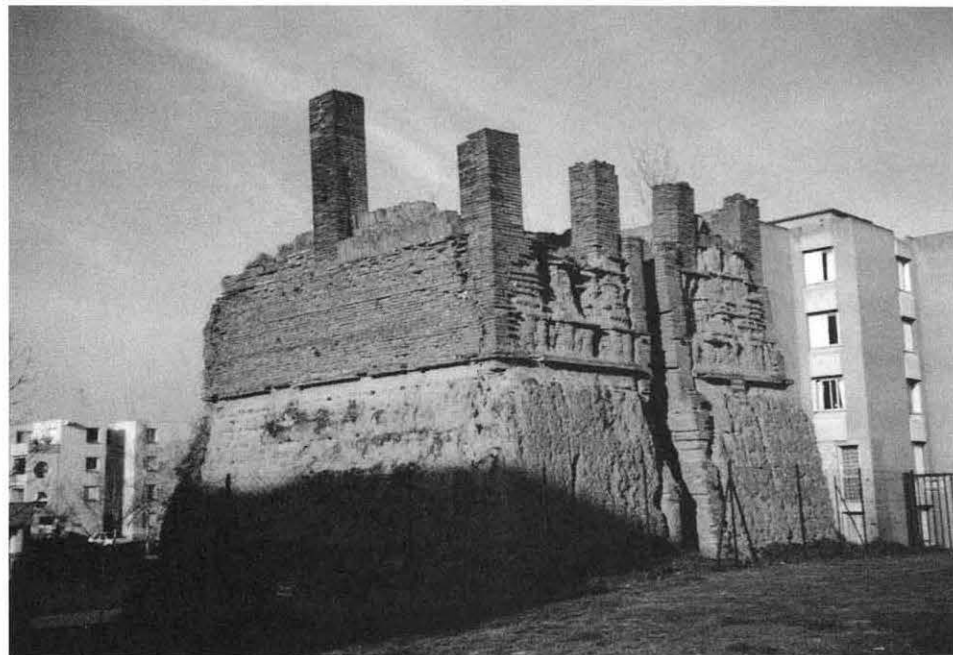
La briqueterie Darbas aujourd'hui : on distingue les marques laissées par les "postes" le long du "pas" (coll. personnelle)
