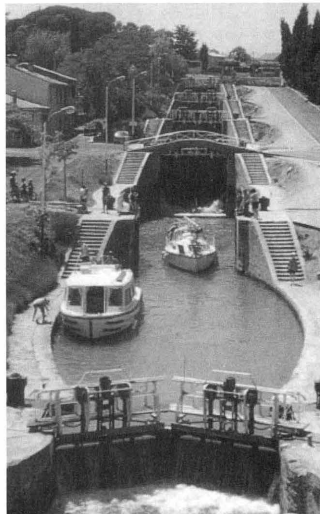
Les écluses de Fonserannes aujourd'hui.
