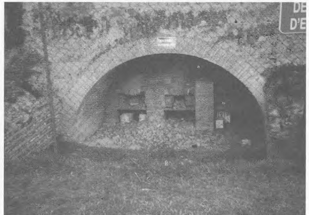
Le four de la dernière briqueterie blagnacaise à jamais éteint.
