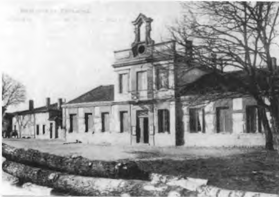
La Mairie-Ecole avec son étage et son campanile, mais sans la grille initialement prévue, telle qu'elle se présentait il y a un siècle, alors située à la périphérie du centre.
