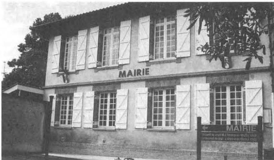
Mondeville Sa rénovation date du début des années 90.
