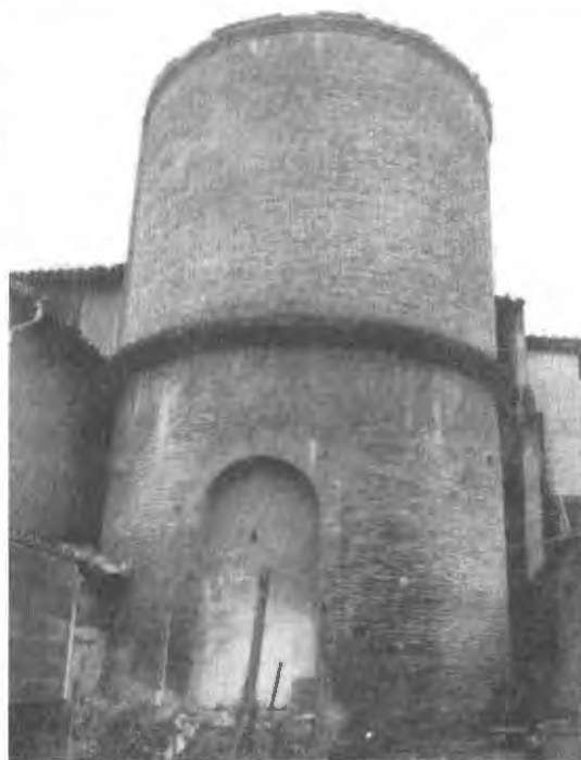
Le château d'eau côté jardin.
