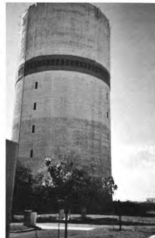
Route de Grenade : le plus grand des trois châteaux d'eau
