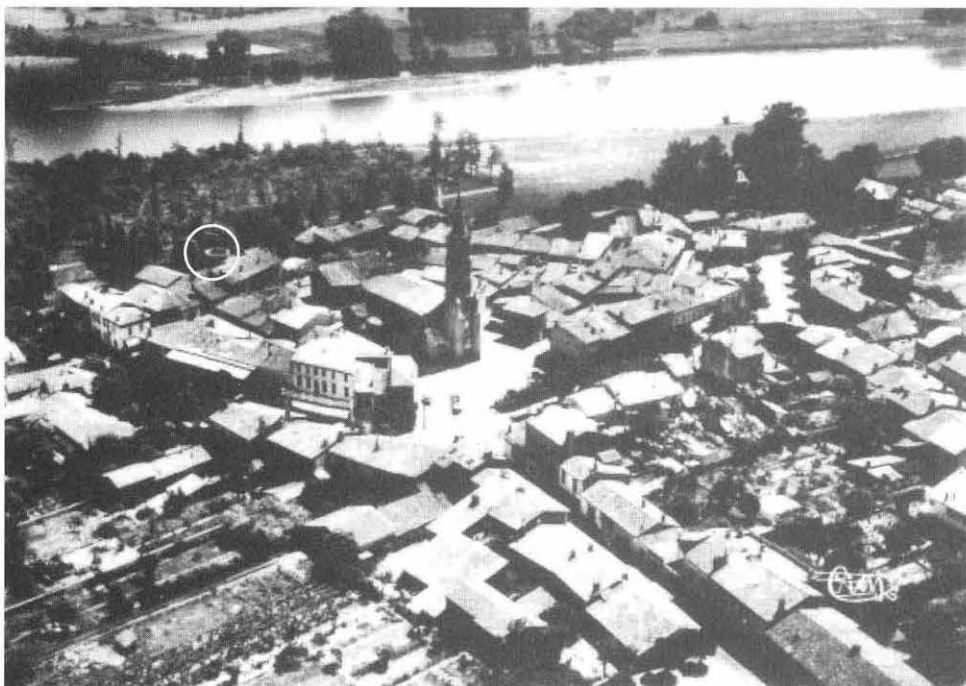
Le château d'eau dans les années 60 avec vue sur le ramier et la Garonne.
