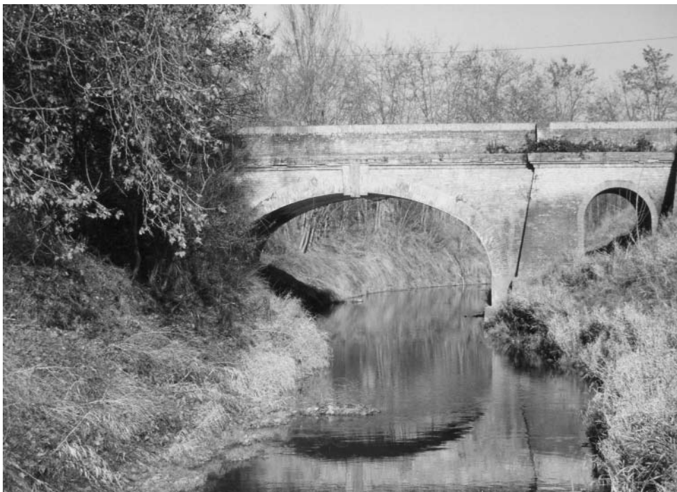
Le pont de la route n° 7 avec, à droite, une des deux arches de sauvetage.
