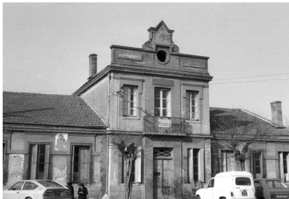
La mairie-école (Jean Jaurès) avant sa démolition (photo Julio Kermel)
