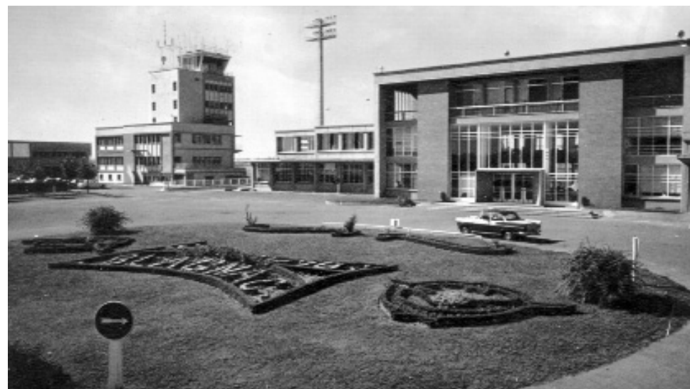
Entrée de l'aérogare, à gauche la tour de contrôle.
