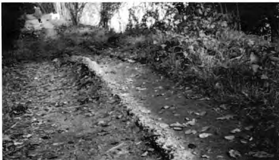
Vestiges de la digue de Soeur Hildegarde en aval du pont de Blagnac
