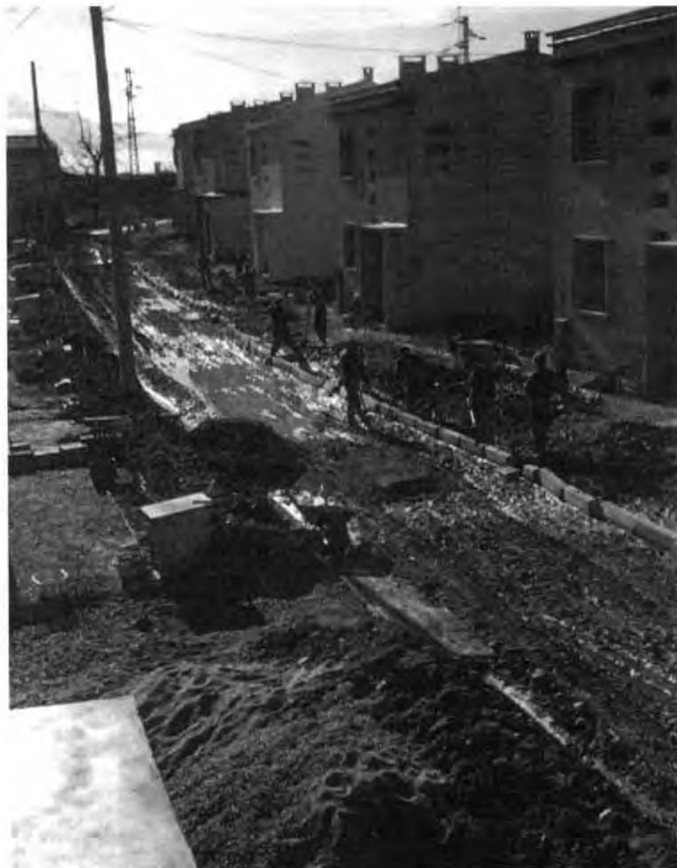
Empierrement, bordures, caniveaux. Les maisons sont habitées depuis 7 mois. 26 mai 1959
