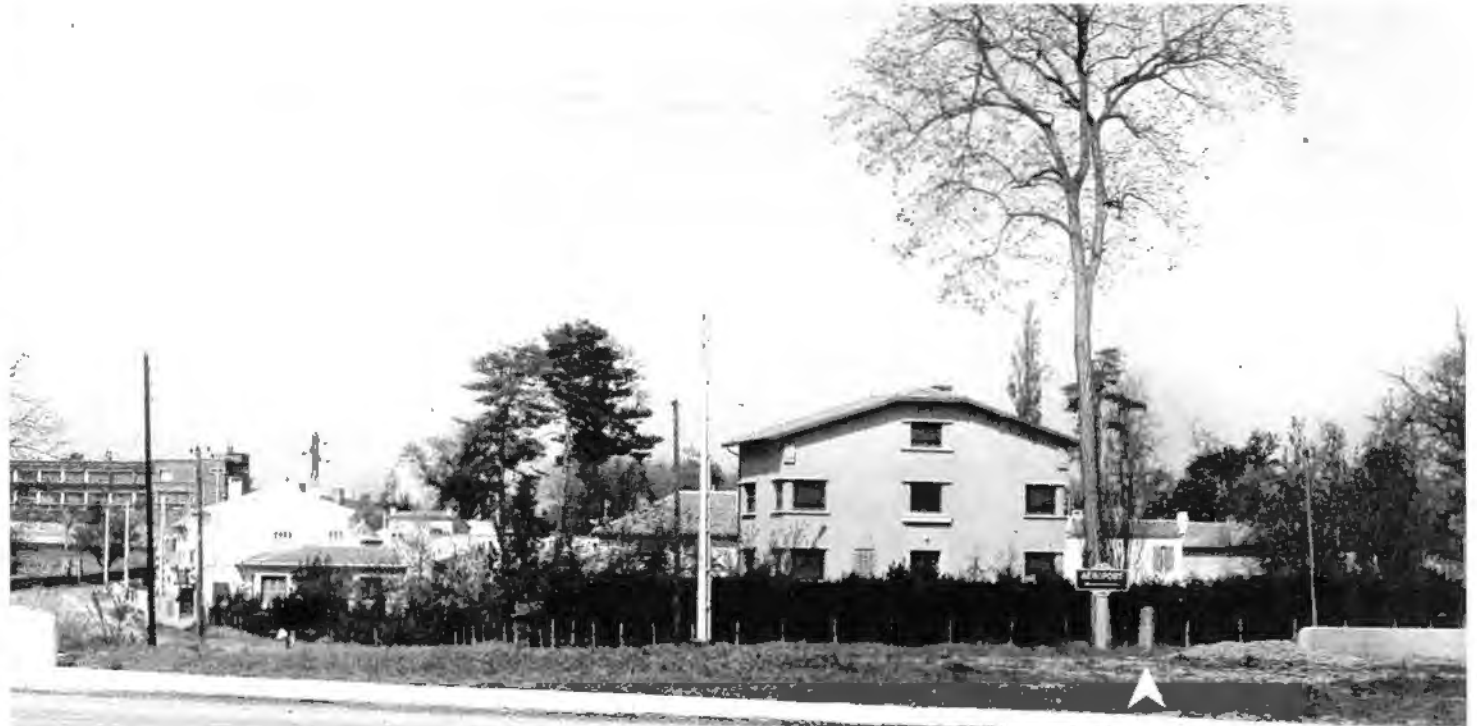
La borne sur son emplacement primitif au carrefour du Pont du Touch près du panneau Aéroport. A gauche, avenue Pierre-Georges Latécoère : de Lectoure à Toulouse par St-Paul. A droite, route de Grenade : de Toulouse à Beaumont par Grenade (collection J-L Rocolle)
