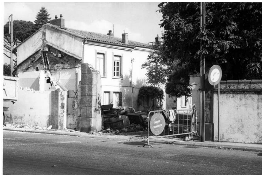
Travaux de démolition en 1977.
