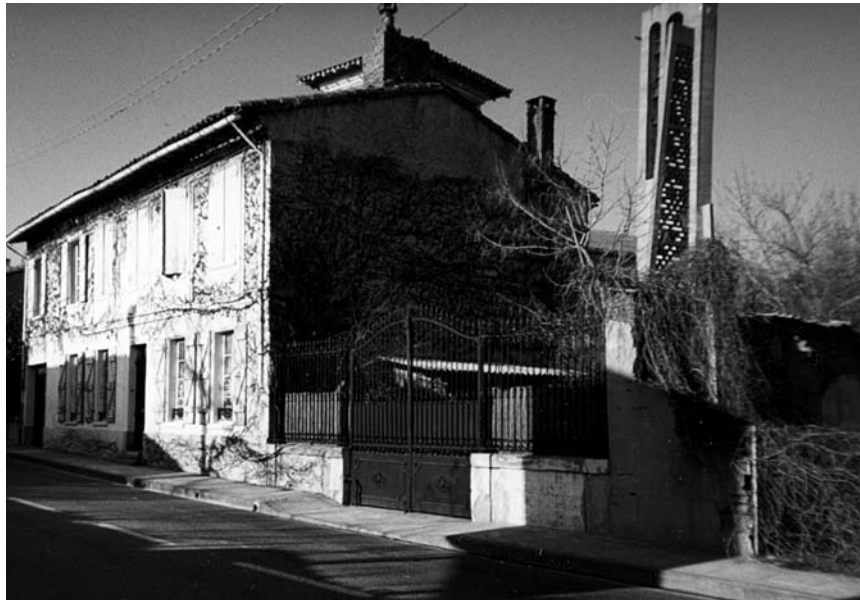
Maison Lormand à Saint-Martin-du-Touch
