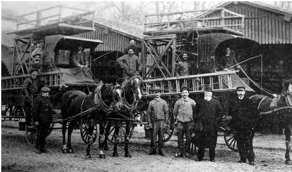
Firmin Pons et son équipe de réparation de câbles électriques aériens Collection J. Sicart
