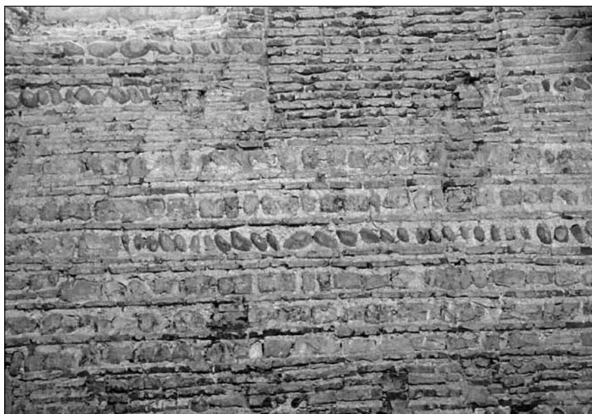
◀ Détail de l'appareil de briques, moellons et galets, sous la fenêtre, dans la première travée
