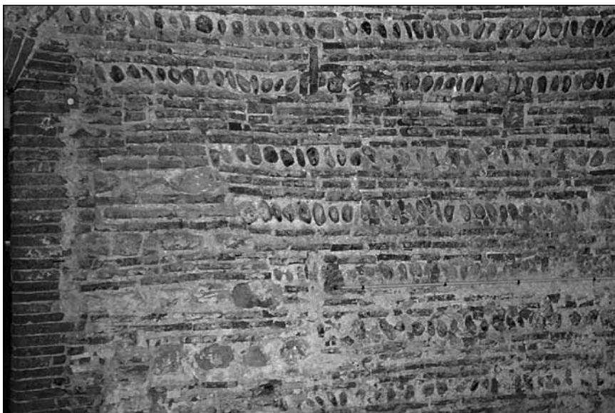
◀ Détail de la reprise en briques et moellons dans l'appareil de briques et galets de l'abside
