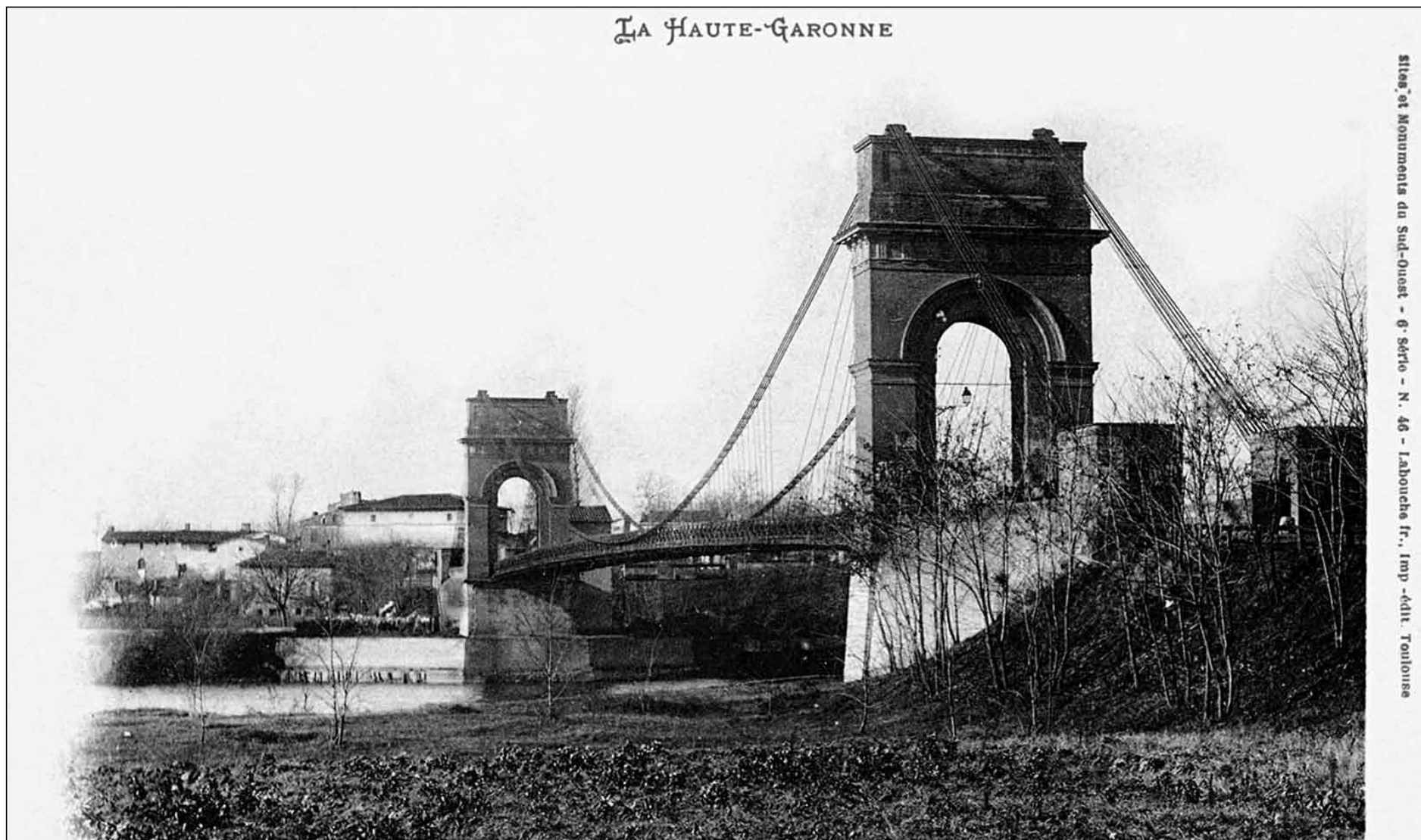
CPA - Premier pont de Blagnac sur la Garonne
