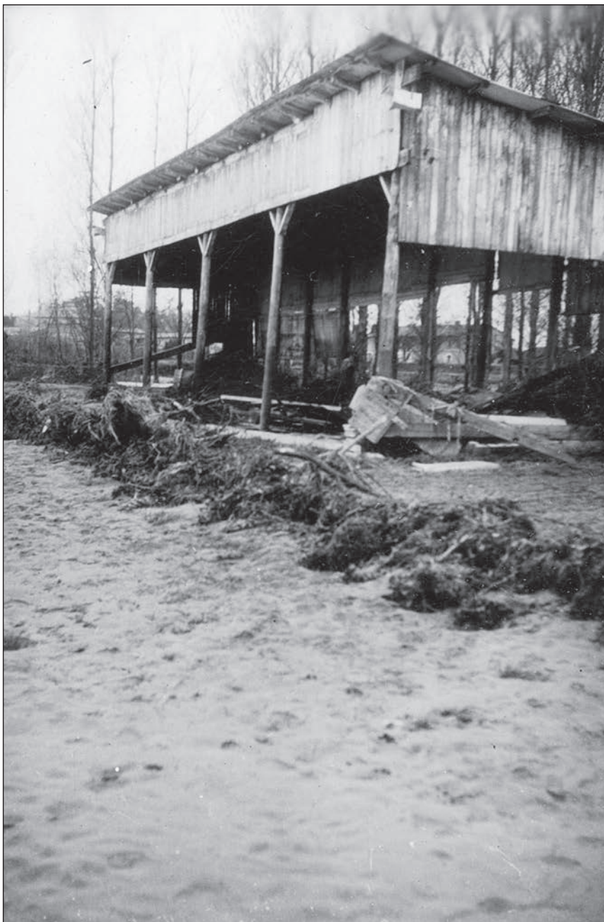
◀ Les tribunes après les inondations de 1952.
