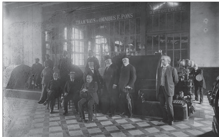
▶ Firmin Pons devant la dynamo de la centrale électrique du Boulevard de La Marquette Crédit photo Archives Municipales Toulouse
