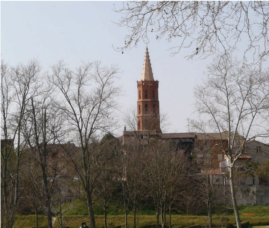
▼ L'église vue de la digue
