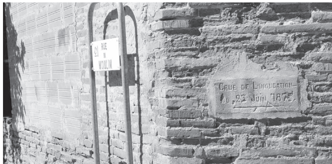
La crue millénaire dans la rue du Moulin (CPA collection BHM) ▲
