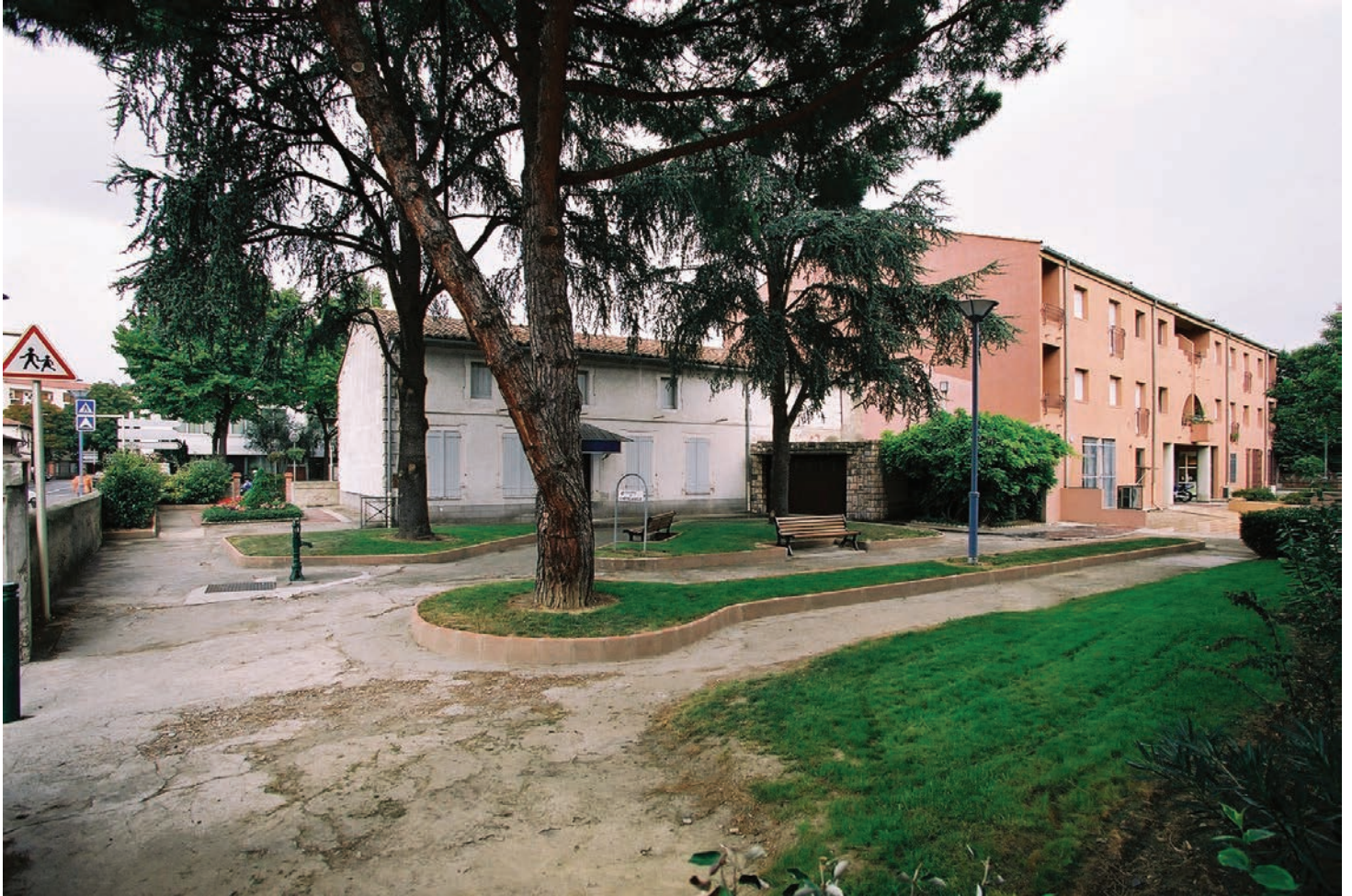
La maison Guimbaud avant 2000 : le crépi recouvre encore la façade arrière (Photothèque municipale de Blagnac)
