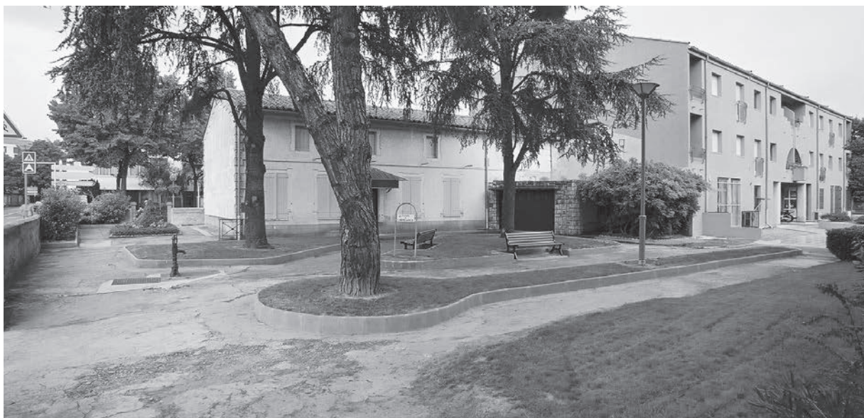
La maison Guimbaud avant 2000 : le crépi recouvre encore la façade arrière (Photothèque municipale de Blagnac)
