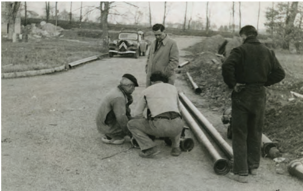
Pose de canalisations dans le Ramier par les employés municipaux en présence du maire Jean-Louis Puig (collection : famille Ricard)
