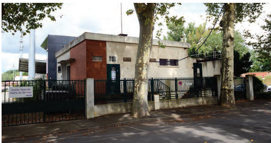
L'usine du Ramier à l'angle du terrain de rugby. (cliché PhG)
