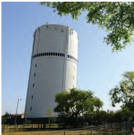
Le château d'eau des Allières encore en service (cliché PhG.)
