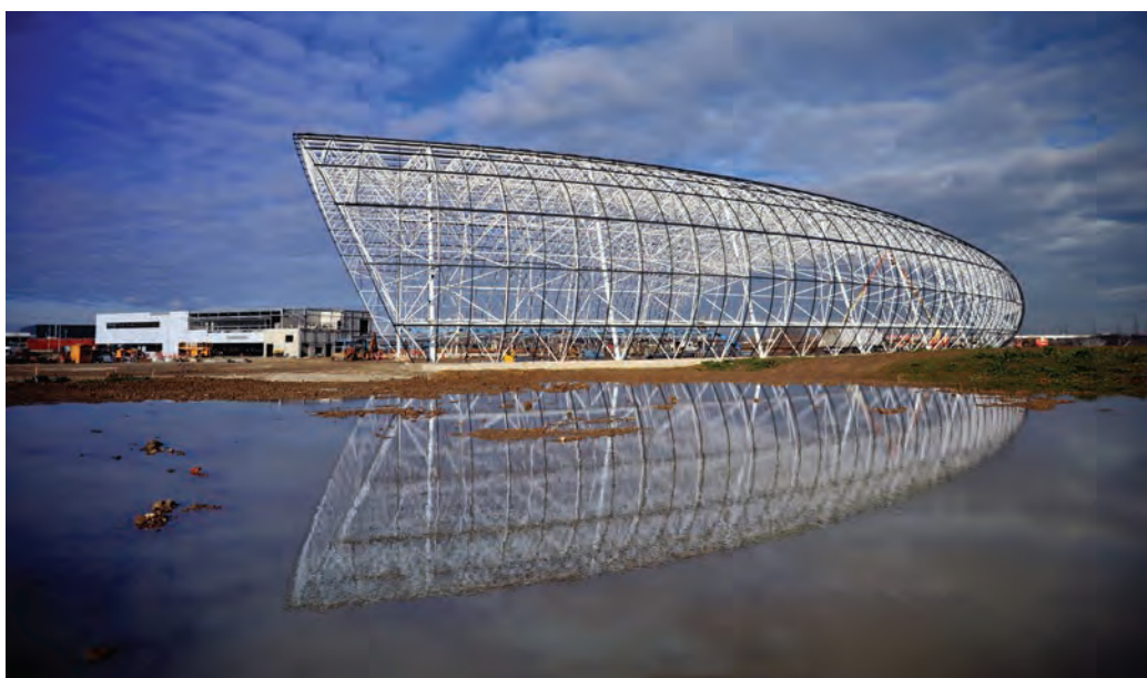
La résille du hangar © Aéroscopia
