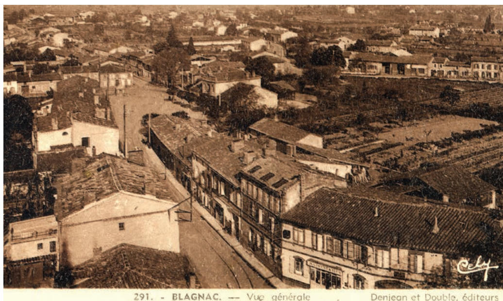
291. - BLAGNAC. — Vue générale
