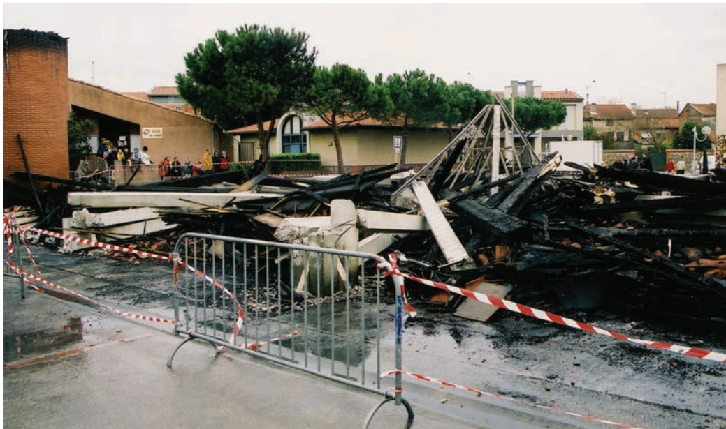
Restes de la halle (photothèque municipale)
