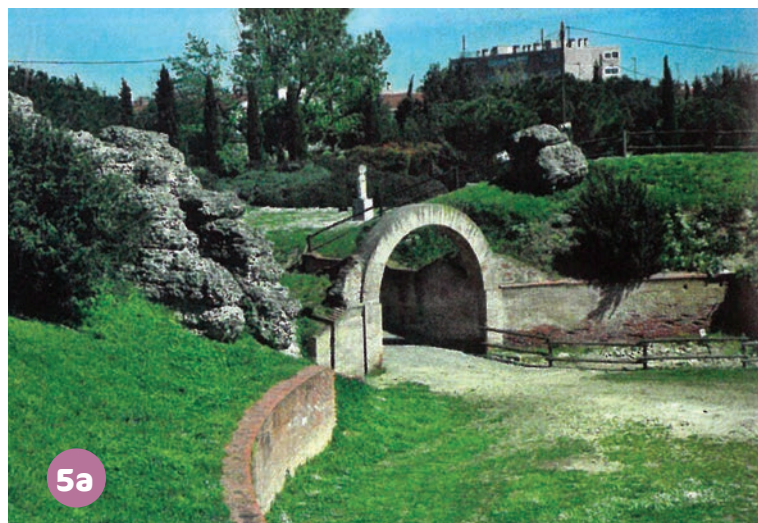
Entrée Nord. Cliché UTAH
