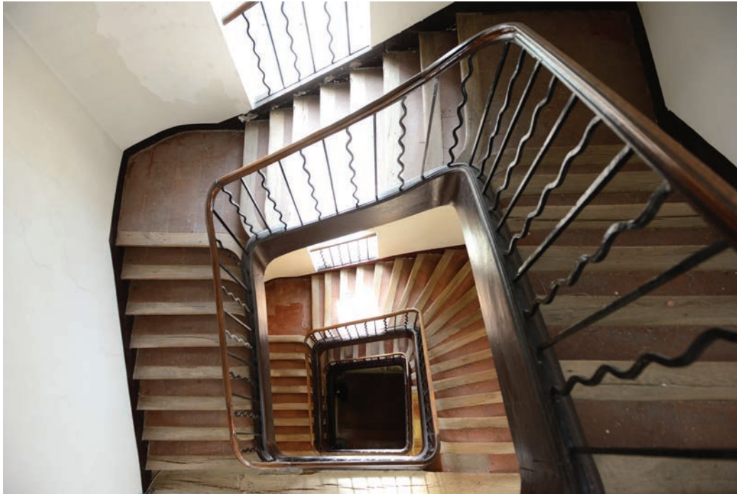
L'escalier intérieur du château de Maniban
