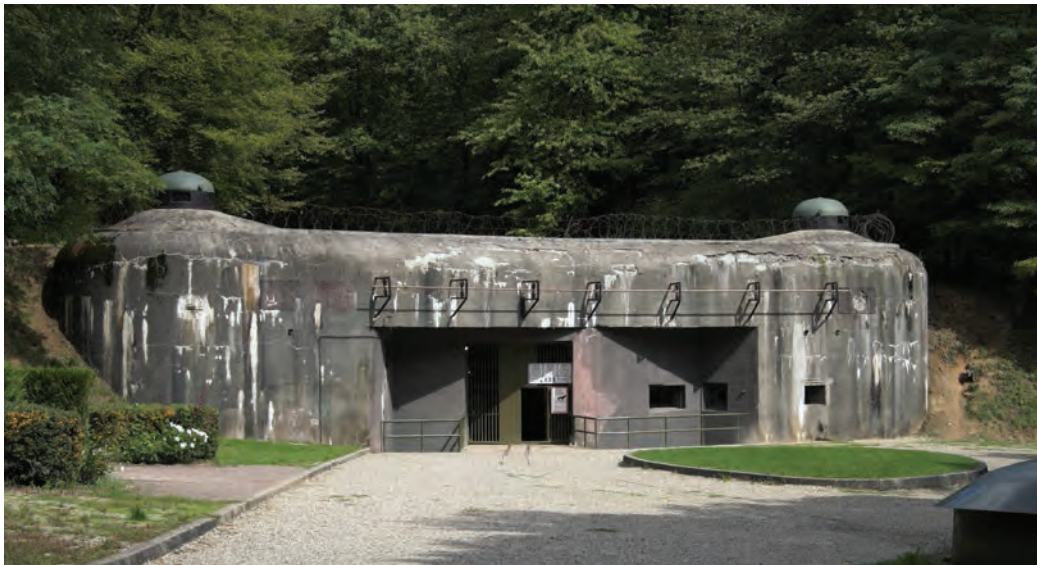
Casemate sur la Ligne Maginot
