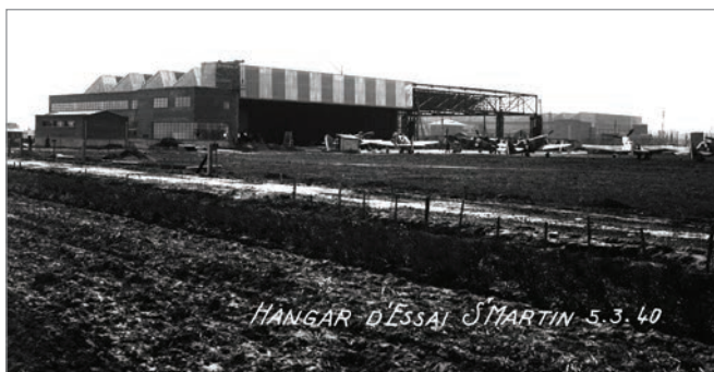
Le hangar d'essais de Saint-Martin du Touch
