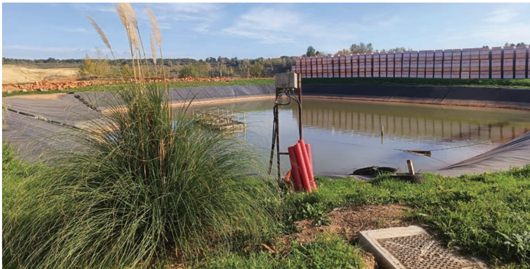
Le bassin de rétention
