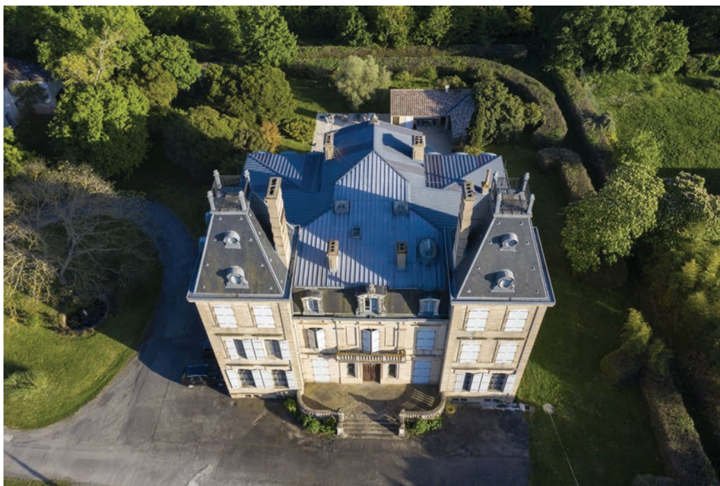
La façade nord du château et ses deux pavillons
