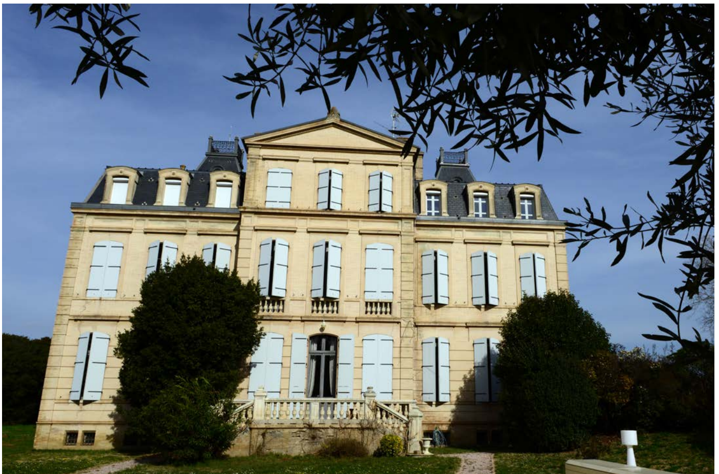
La façade sud du château du Ferradou - photo BHM
