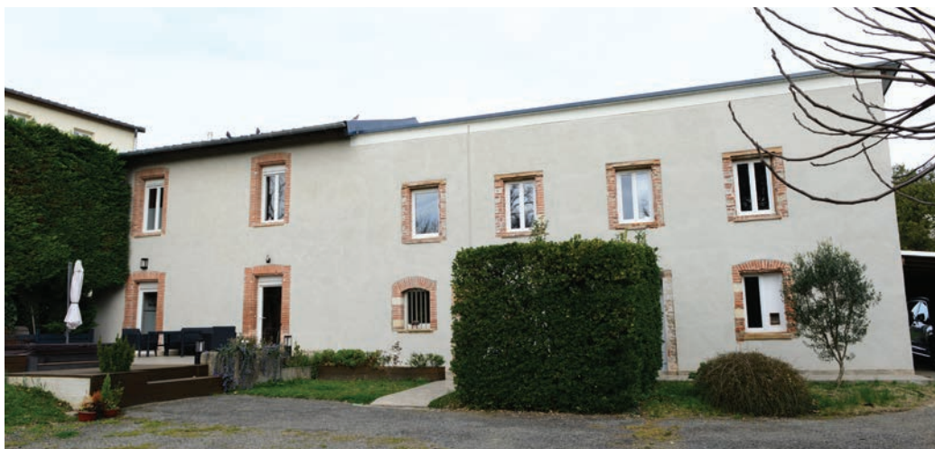
Le bâtiment de l'ancienne métairie du domaine du Rieu
