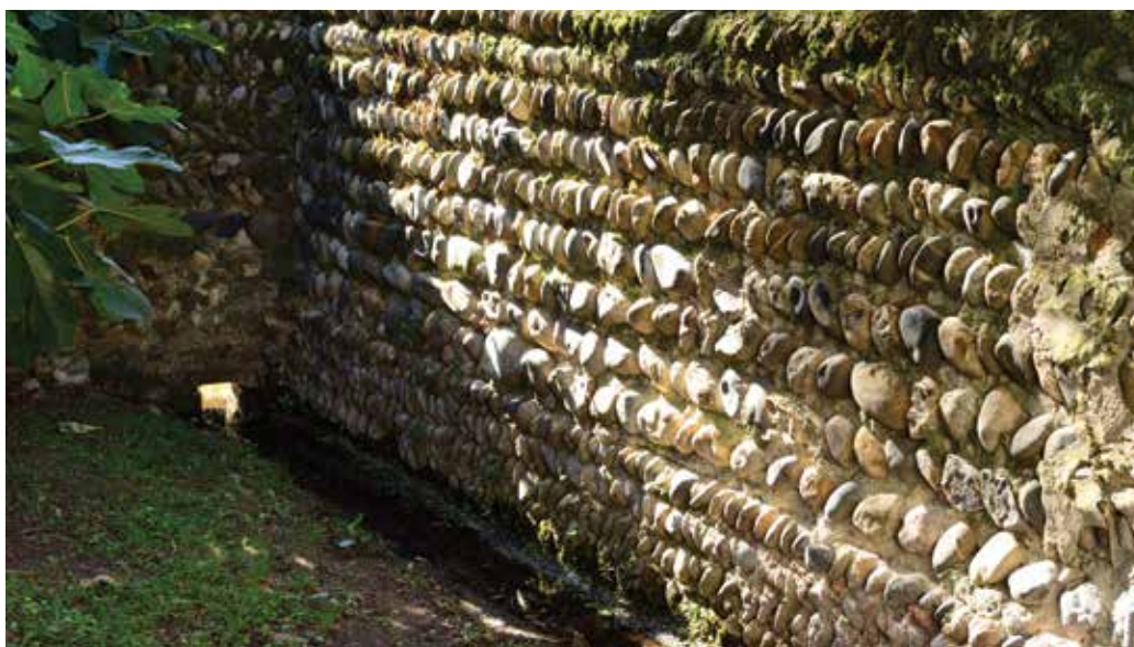
Au pied du mur en opus spicatum, un des nombreux canalets (Photo BHM)
