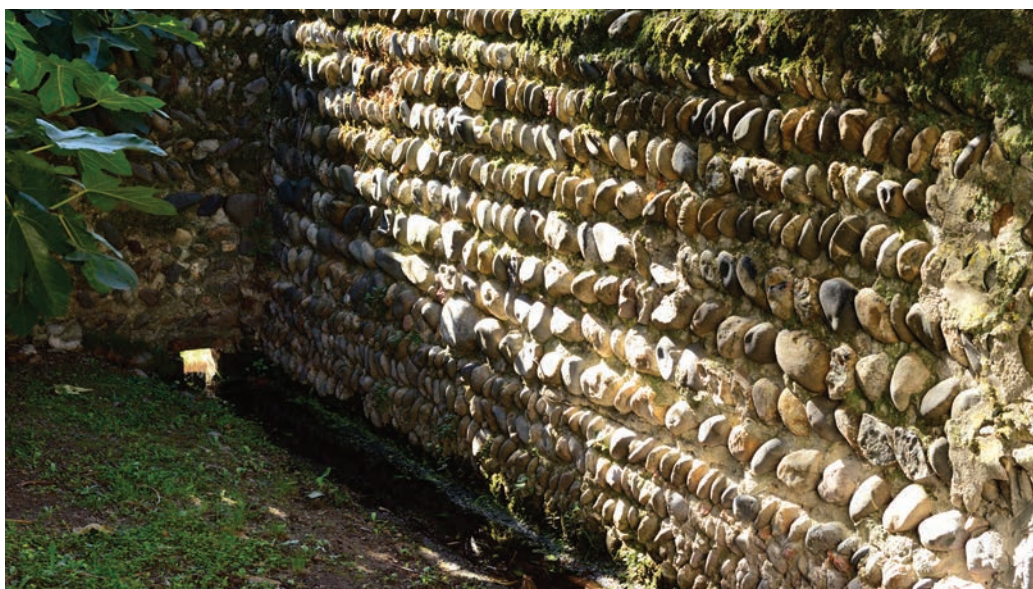
Au pied du mur en opus spicatum, un des nombreux canalets (Photo BHM)
